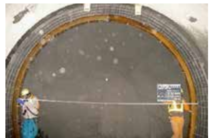
写真4 鋼製支保の設置
