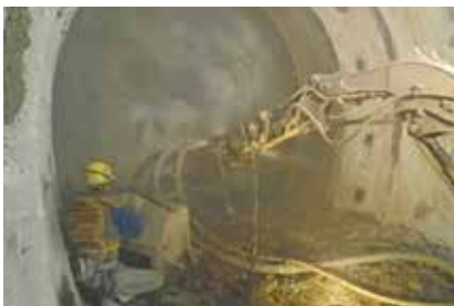
写真5 コンクリート吹付け
